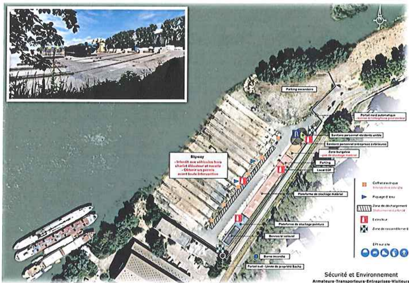
Figure 1 : vue aérienne du site (Source dossier)
